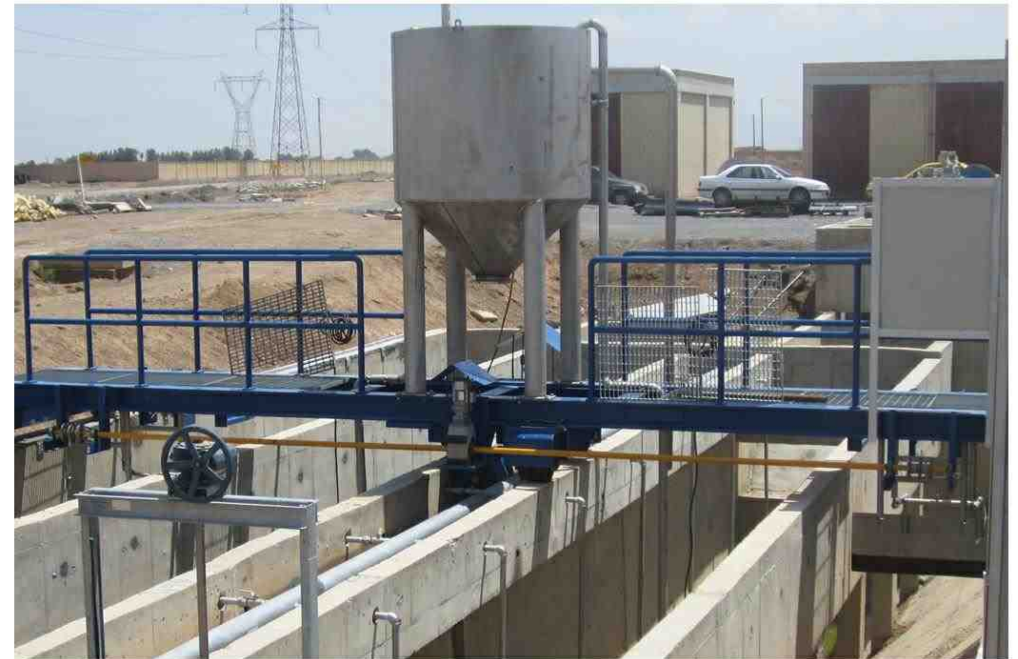
تصميم وإنشاء وتركيب جسور إزالة الحمأة والترسيب (مشروع تنقية مياه الصرف الصحي البلدية)
