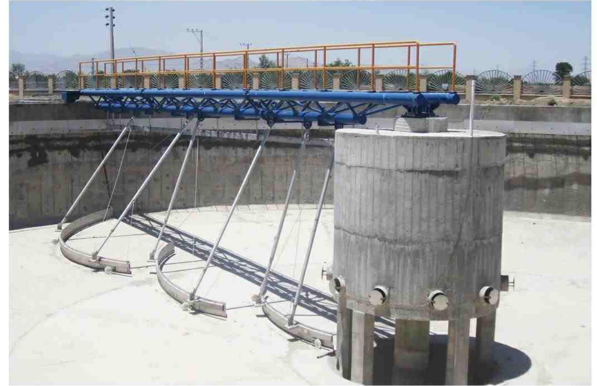
تصميم وإنشاء وتركيب جسور إزالة الحمأة والترسيب (مشروع تنقية مياه الصرف الصحي البلدية)
